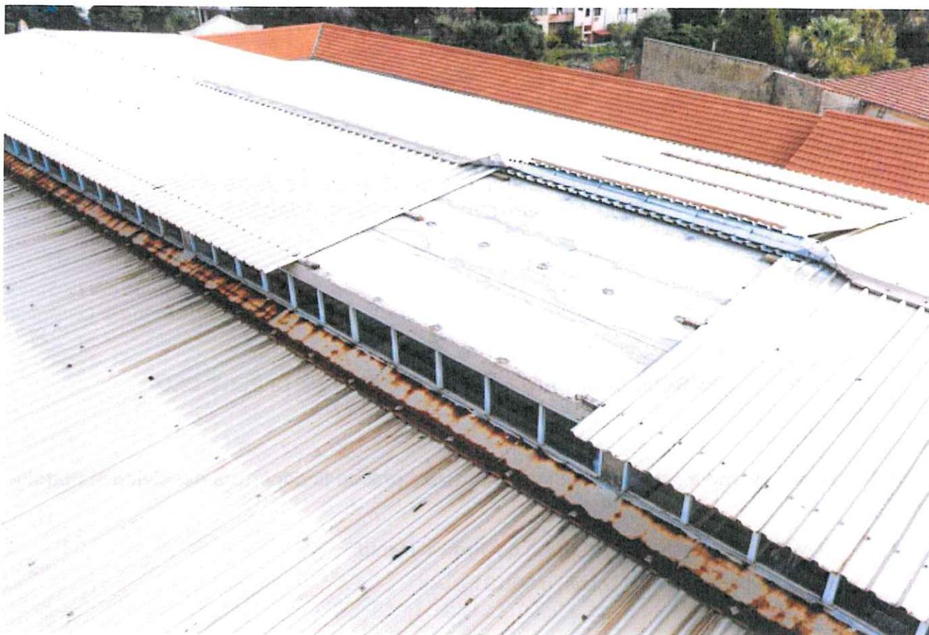
Come si può ben notare dalle fotografie, il pannello divelto dal vento ondeggia da un lato a l'altro della copertura a seconda della direzione del vento, ed è tenuto esclusivamente sulla linea di colmo. Ciò con l'andar del tempo di fatto provoca la rottura della linea di colmo con la caduta del lamierato.
