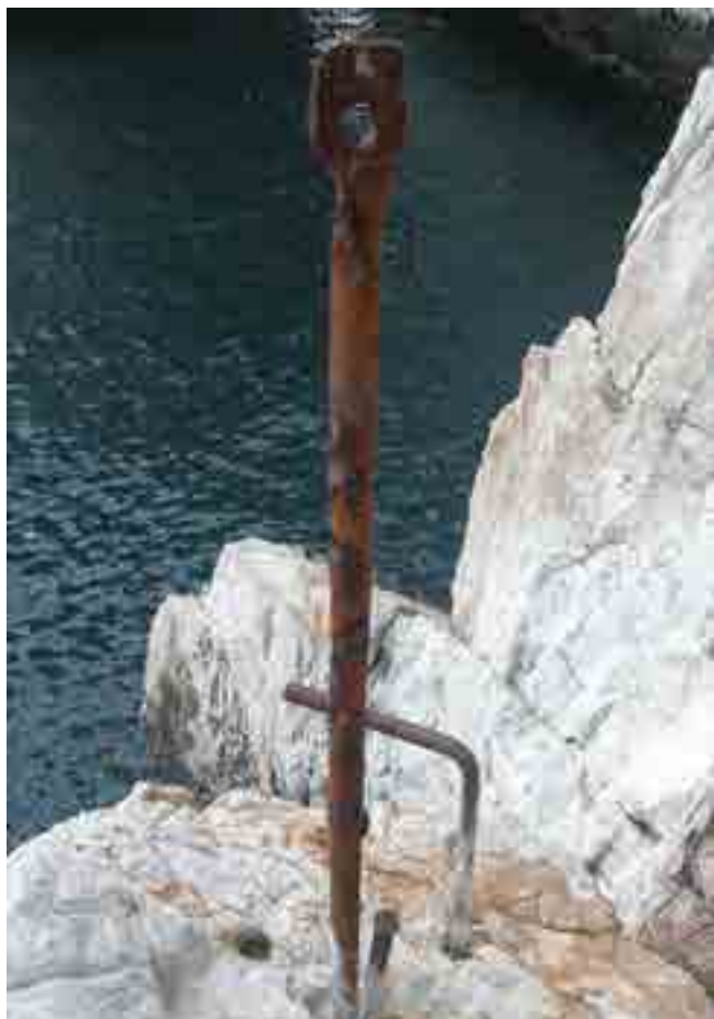
Ferri infissi nella roccia in prossimità del pozzo a mare
