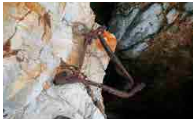
Pozzo a mare: rinvenimento di ferramente utile per il calo del materiale
