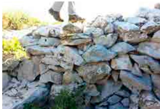
Passaggi in pietra posati dai minatori
