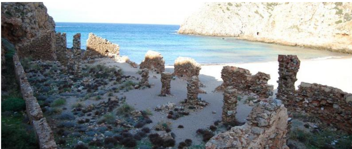
Figura 36. Magazzino per il deposito dei minerali di Cala Domestica
