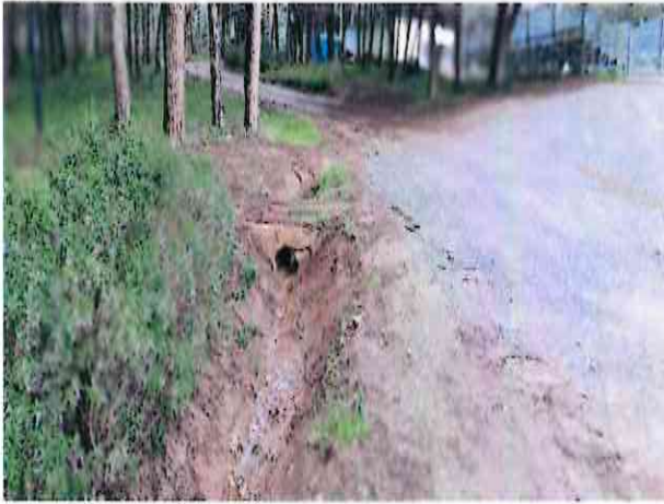
Cavalcafosso Via dei Pini
