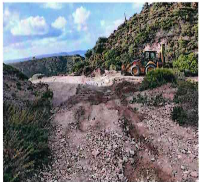
Intervento di sistemazione della parte alta della Via Chessa con formazione cunetta
