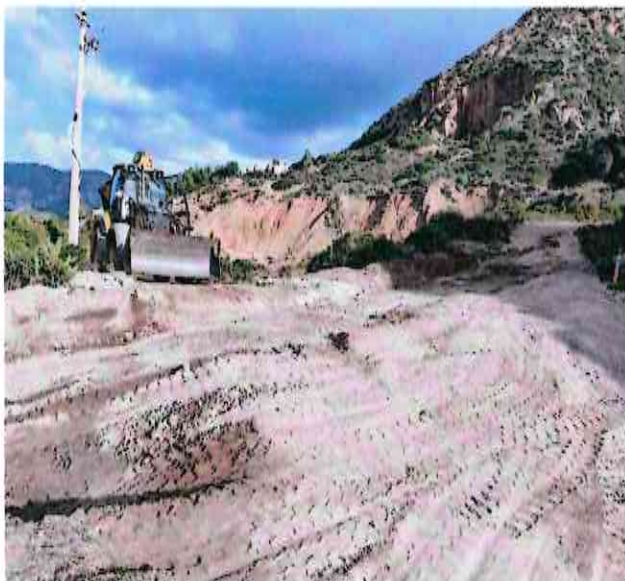
Intervento di sistemazione della parte alta della Via Chessa con formazione cunetta
