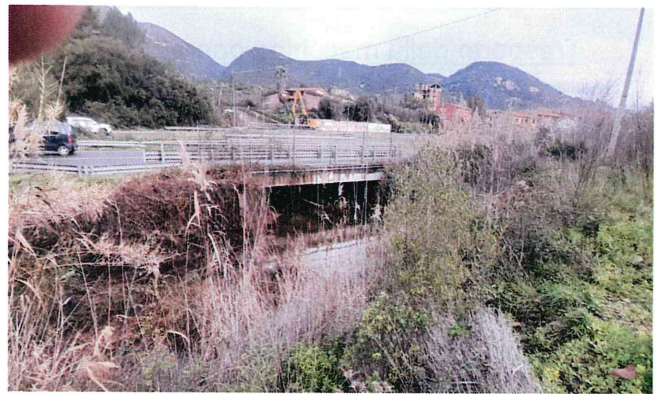
Attività a valle del ponte
