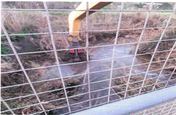
Attività a valle del ponte
