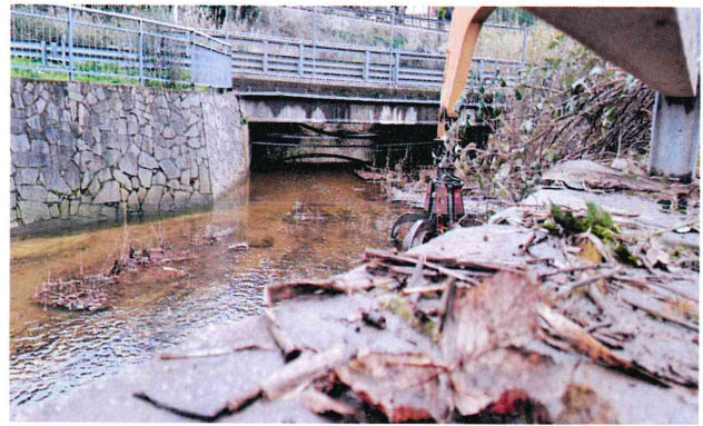
Proseguo attività a monte del ponte
