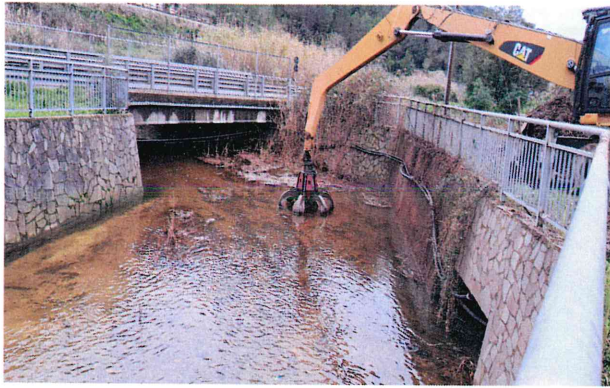
Proseguo attività a monte del ponte
